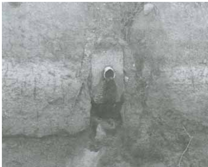
عکس ۶-۱- خروجی زهکش زیرزمینی به کانال جمع‌کننده و مشاهده تجمع رسوبات آهن
