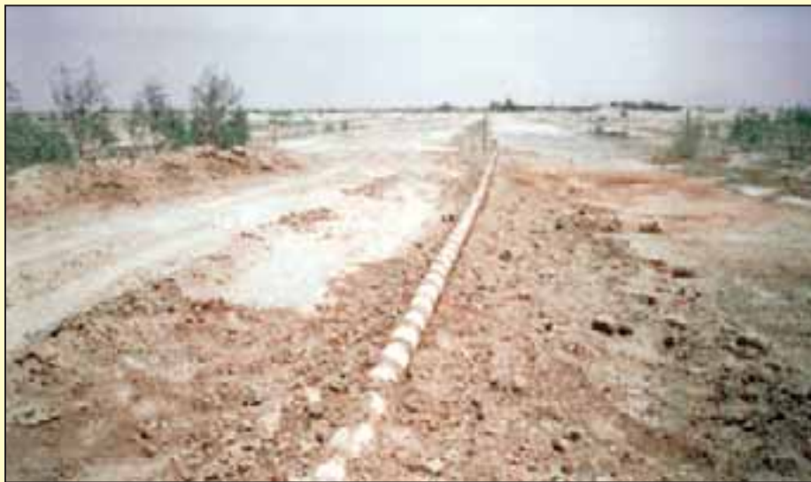
شکل ۱: نحوه اجرای سیستم آبیاری لوله سفالی در مناطق بیابانی
